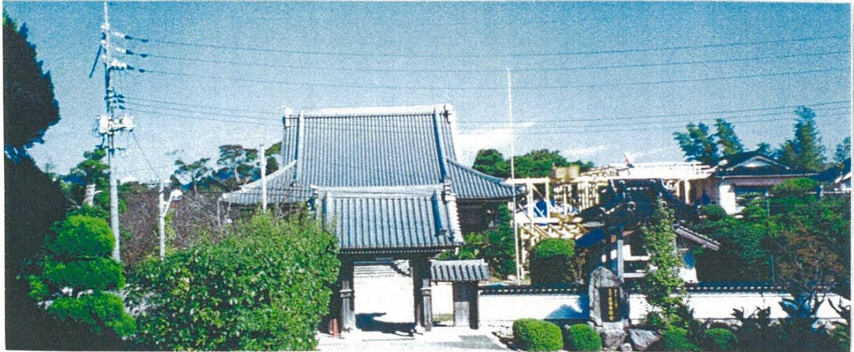
完成した本堂山門の瓦葺と改修中の庫裡
